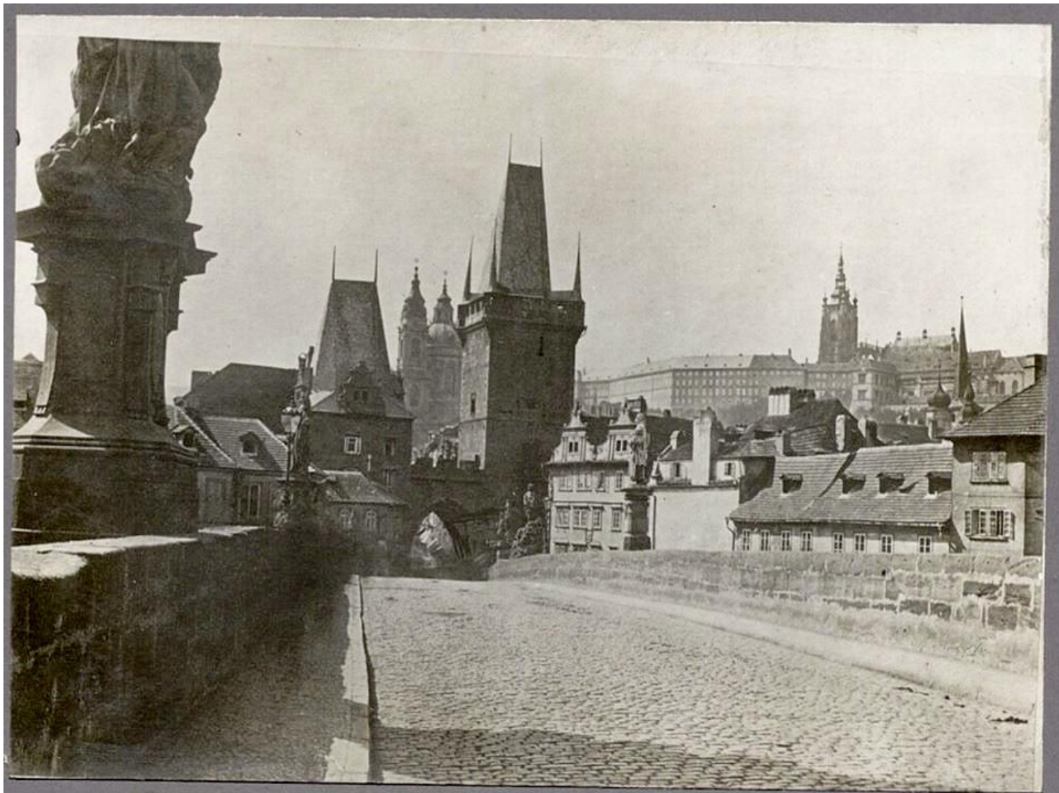
Malostranské mostecké věže a Hradčany r. 1866.
