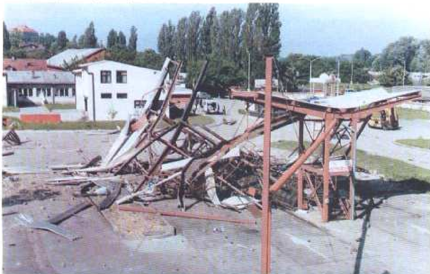
Слика 20 Изглед уништеног аутопретакалишта бр. 1. у складишту горива НИС „Југопетрола“ ул Радничка 3 – Београд, дана 19. 05. 1999. године
