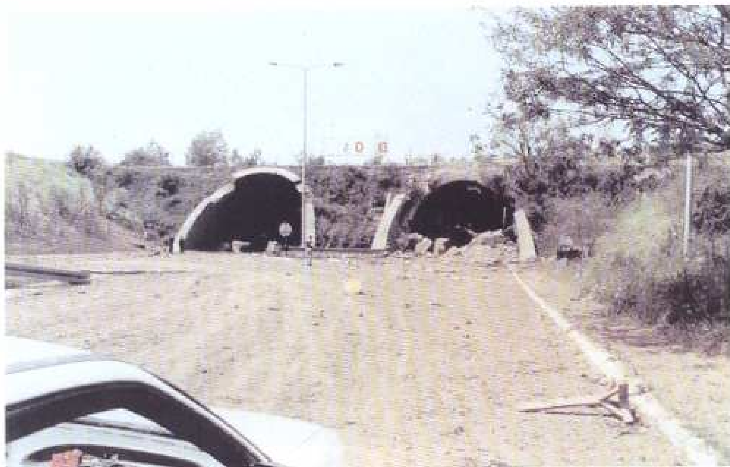
Слика 108 Поновно бомбардовање тунела који води из Сремске Каменице ка мосту „Слободе” у Новом Саду дана 31. 05. 1999. године
