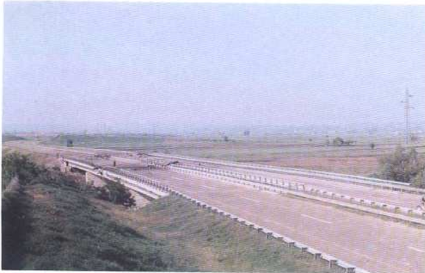
Слика 89 Оштећени мост преко реке Нишаве на аутопуту Београд – Ниш – Лесковац у атару села Поповац, дана 28. 05. 1999. године
