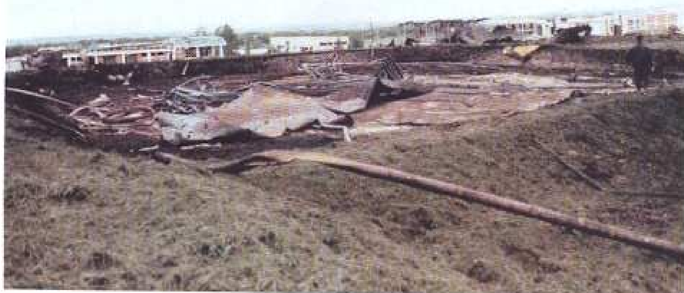
Слика 5 Разрушени резервоар Р-7 у НИС „Југопетрол“ у Нишу, дана 05. 05. 1999. године
