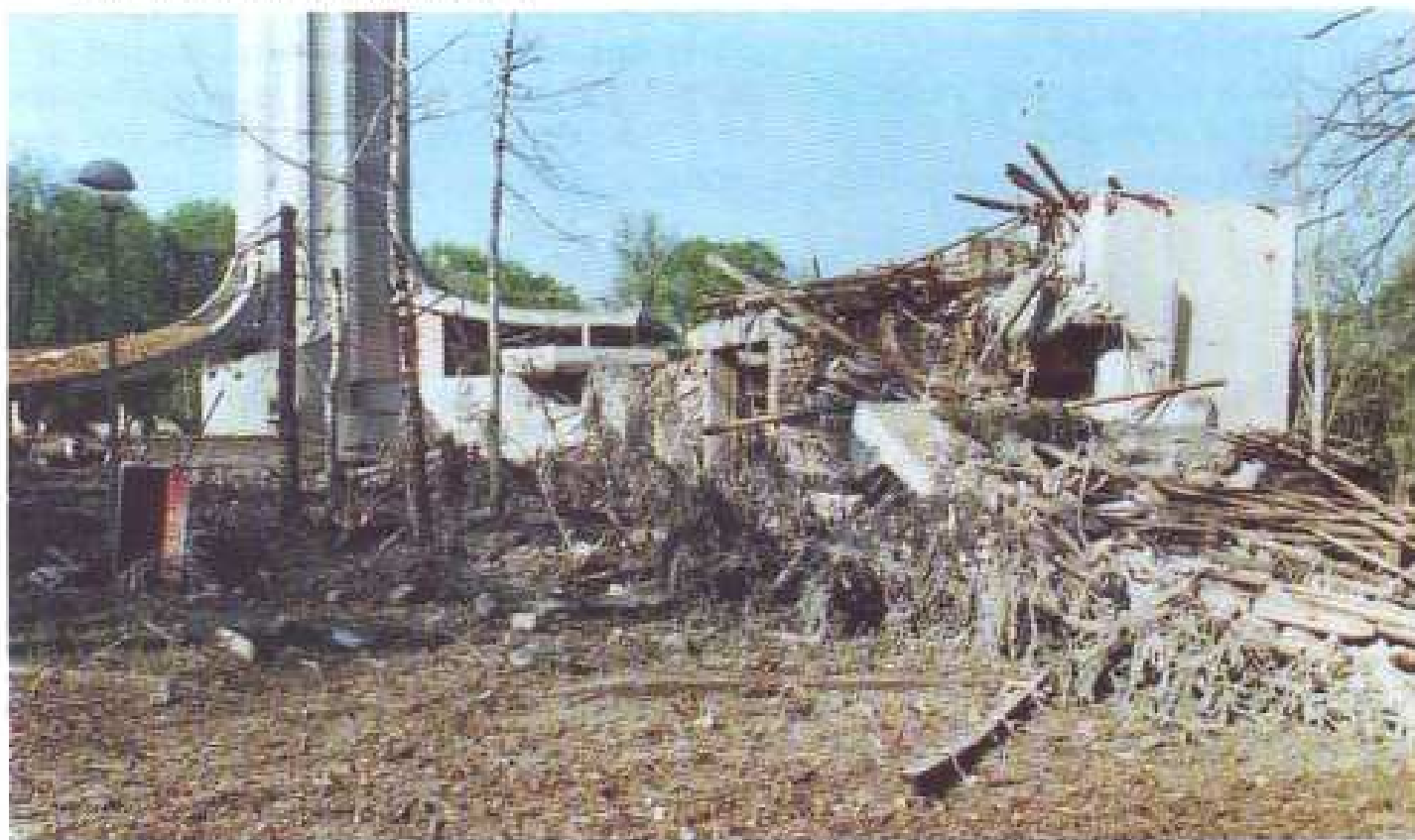
Слика 1 Срушена зграда у подножју торња – предајника РТС-а на Иришком венцу дана 27. 4. 1999. године (први напад)
