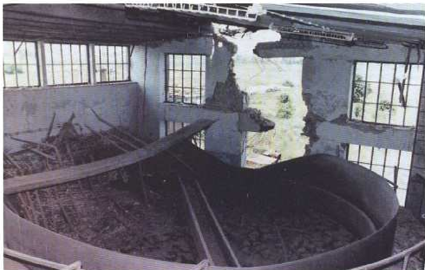
Слика 55 Ближи изглед уништеног резервоара у црпној станици Центра за снабдевање водом „Јарош” у Сомбору, 30. 05. 1999. године
