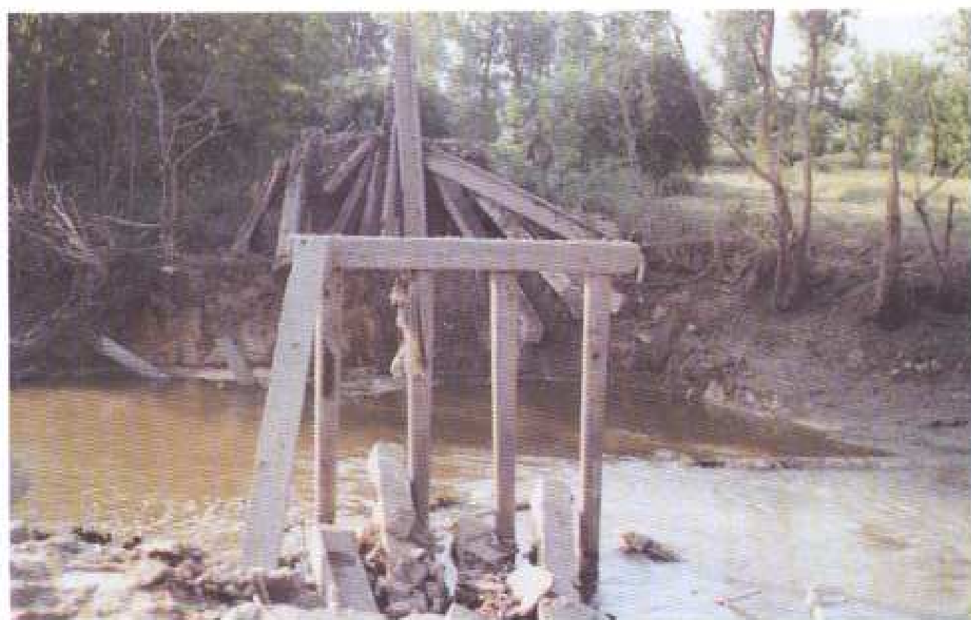
Слика 80 Ближи изглед срушеног „Цекавичког моста” у чијој су близини погинуле Веселка Спасић и Бранка Станковић из Цекавице, 27. 05. 1999. године
