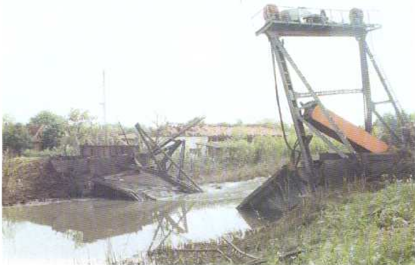
Слика 62 Срушени мост у Његошевој улици у Врбасу, дана 13. 05. 1999. године
