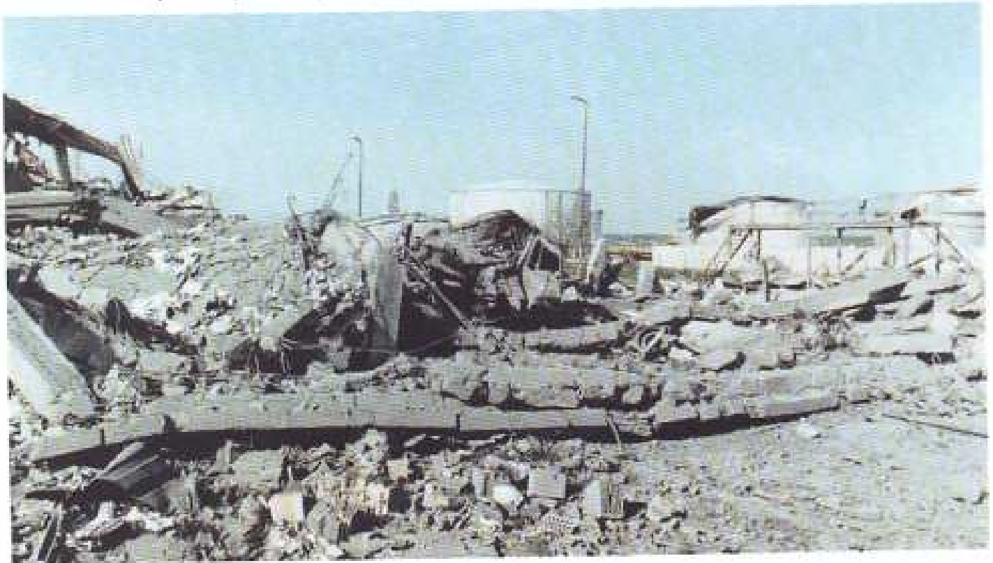
Слика 1 Уништени објекат управне зграде са сервисом у НИС Југопетрол – „Инсталација”, Смедерево дана 29. 04. 1999. године
