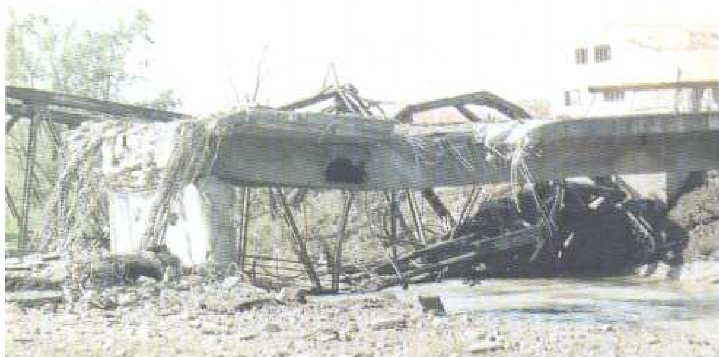
Слика 25 Срушени мост преко реке Расине на путу Крушевац – Дедина у селу Дедина – Крушевац, дана 02. 05. 1999. године
