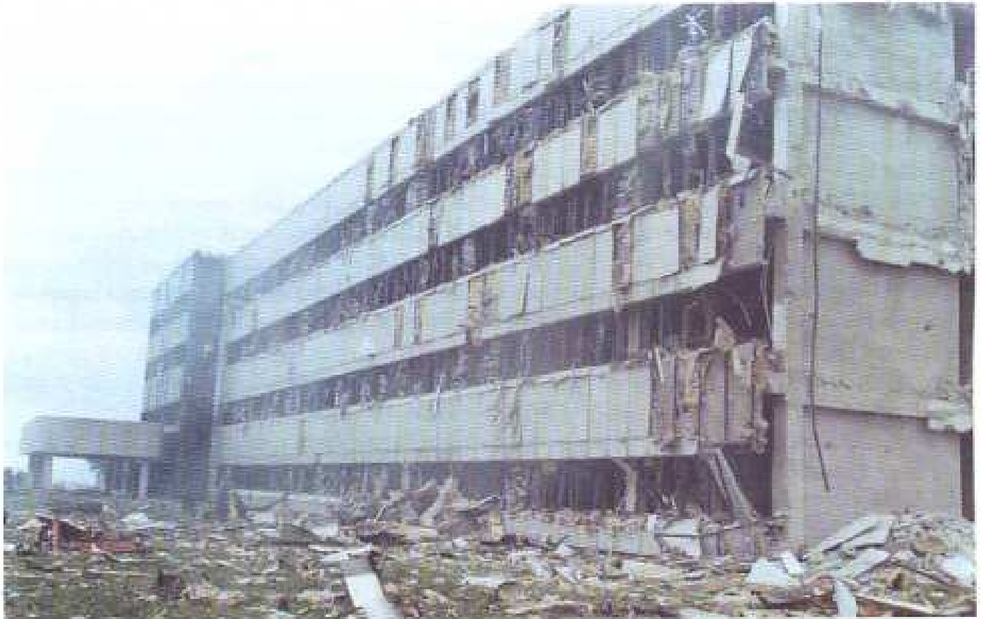
Слика 11 Уништена зграда РТС-а Нови Сад, Каменички пут 45 у Новом Саду, дана 13. 05. 1999. године (други напад)
