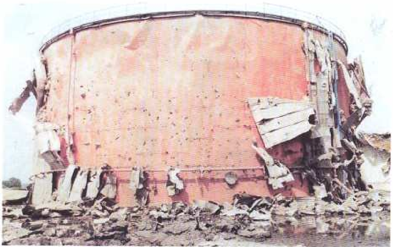
Слика 28 Оштећени резервоар Р-26 са уништеном спољном изолацијом у НИС „Југопетрол” – Инсталације у Смедереву дана 01. 06. 1999. године
