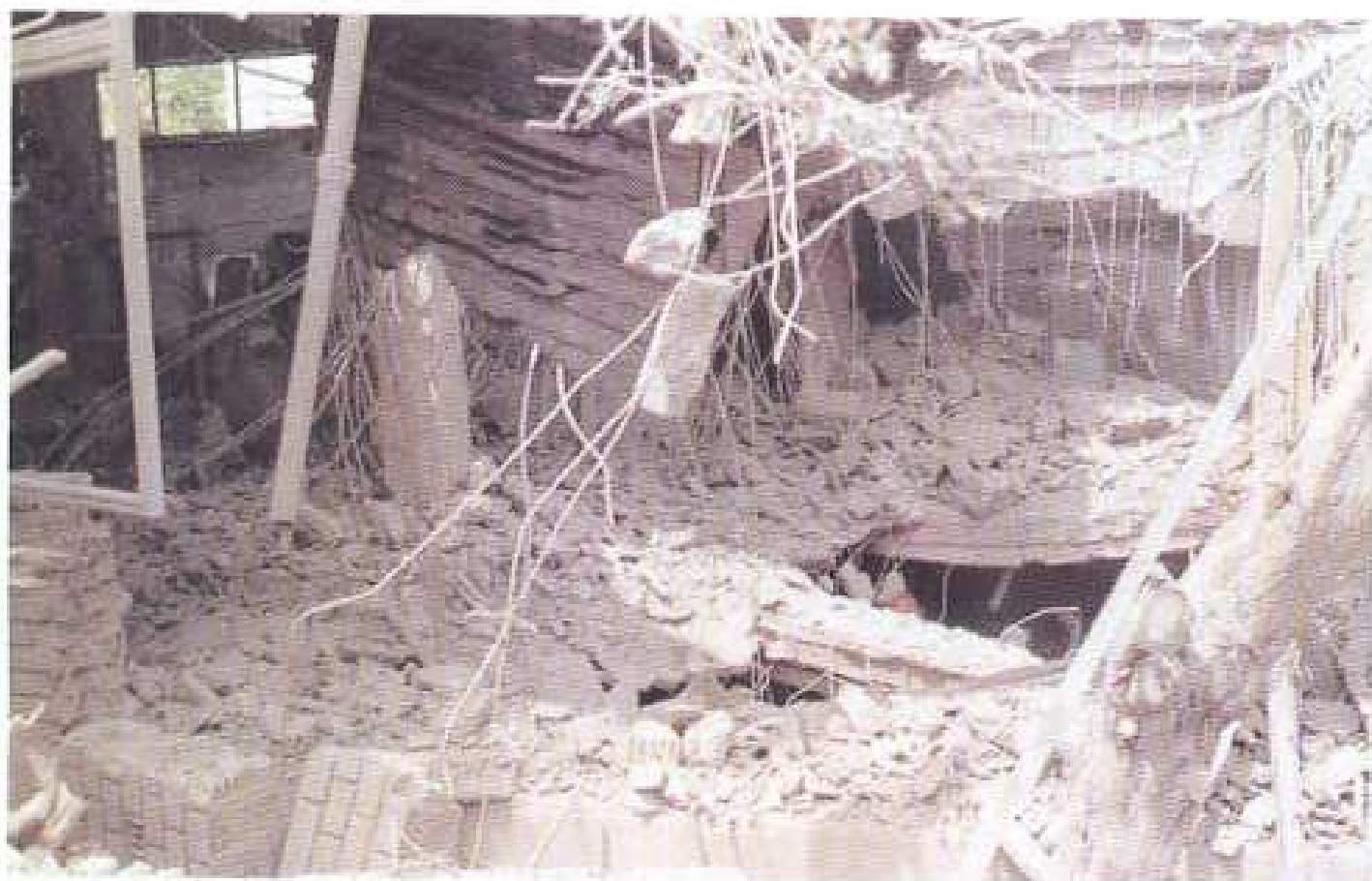
Слика 33 Унутрашњост уништеног ресторана друштвене исхране ПИП „Младост“ у Гњилану, дана 19. 05. 1999. године
