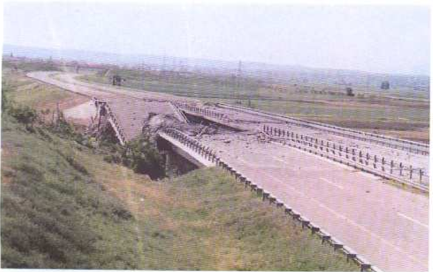
Слика 93 Срушен део моста преко Нишаве на аутопуту Београд – Ниш – Песковац у селу Поповац – Ниш, дана 30. 05. 1999. године (други напад)
