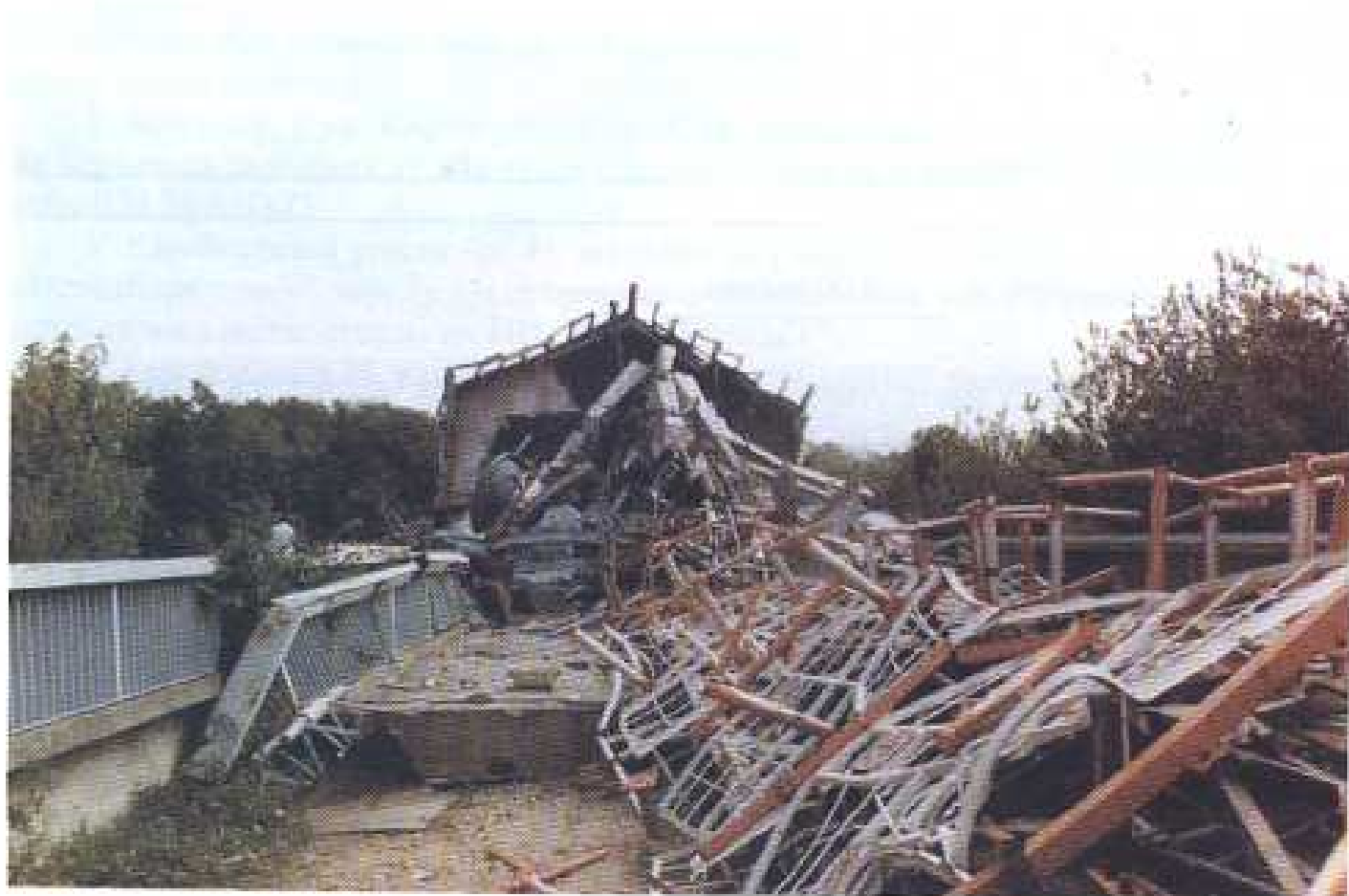
Слика 4 Изглед порушеног антенског стуба на Авали који је био висине 120 м
