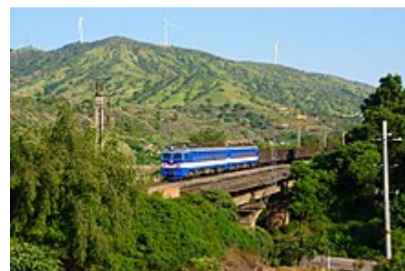
Jižní část železnice Chengdu-Kunming je položena podél řeky Jinsha
