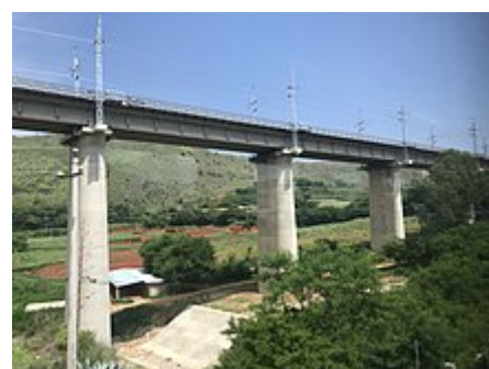
Most přes řeku Longchuan ve vesnici Xiaoxi na dvojitě trati Yong (Ren) Guangzhou (Tong) železnice Chengdu-Kunming byl pořízen v
