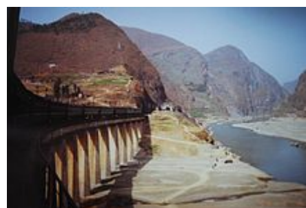
Železnice Chengdu-Kunming spojená mostem a tunelem (foceno v roce 1994)
