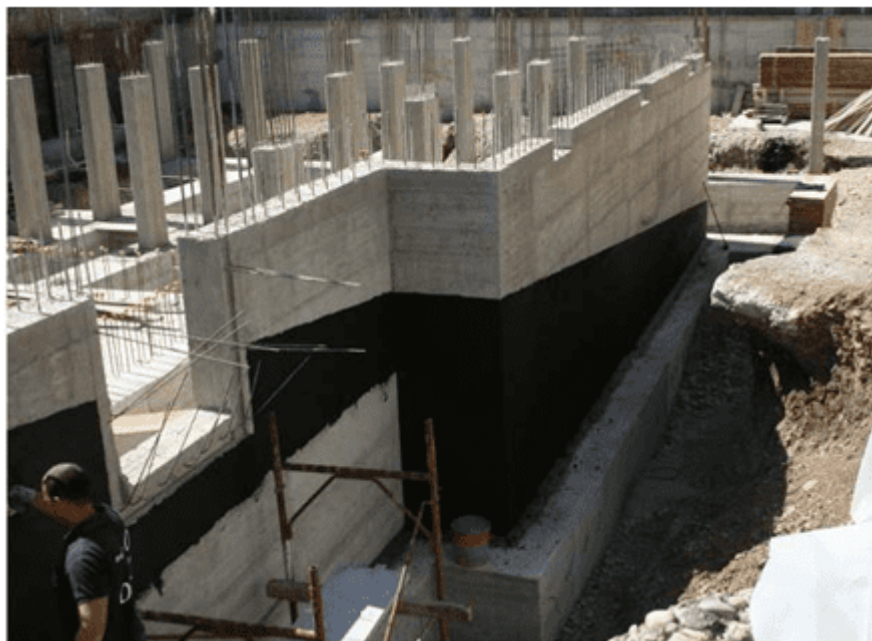
Bitumenový nátěr základů pro hydroizolaci
