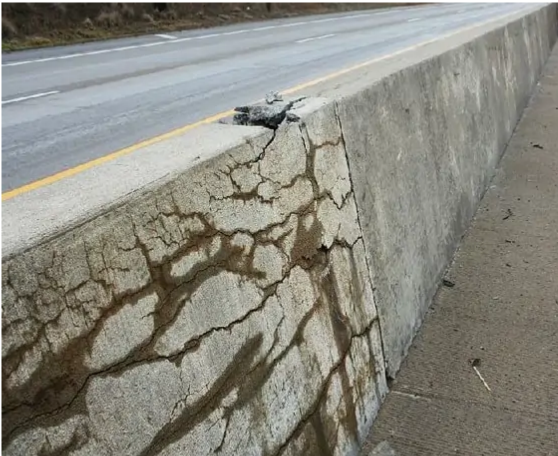
Praskání betonu v důsledku alkalicko-křemičité reaktivity
