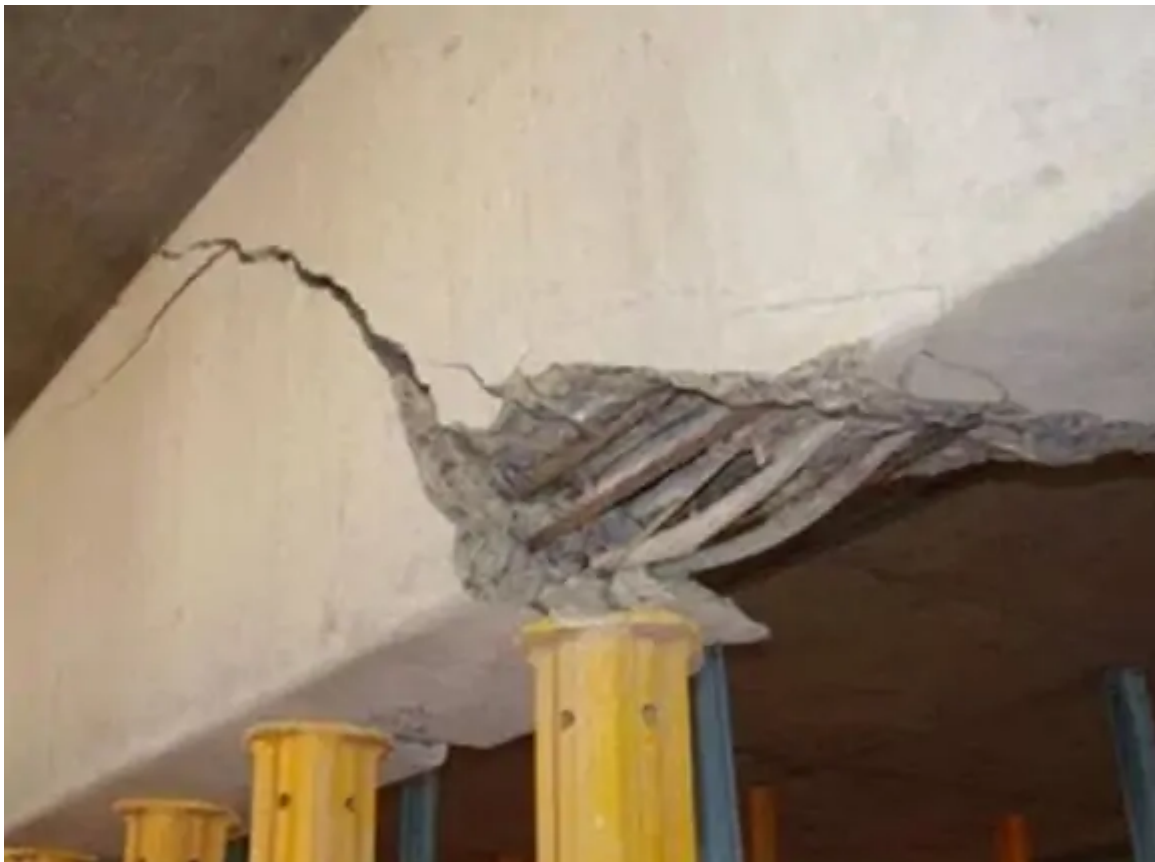
Běžná forma nárazového přetížení se vyskytuje u desky
