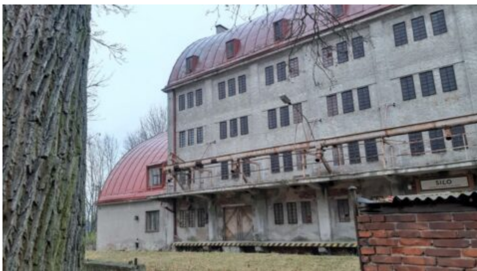
Náhled do bývalé sýpky s unikátní konstrukcí lamelových krovů, v patentním systému zollbau
