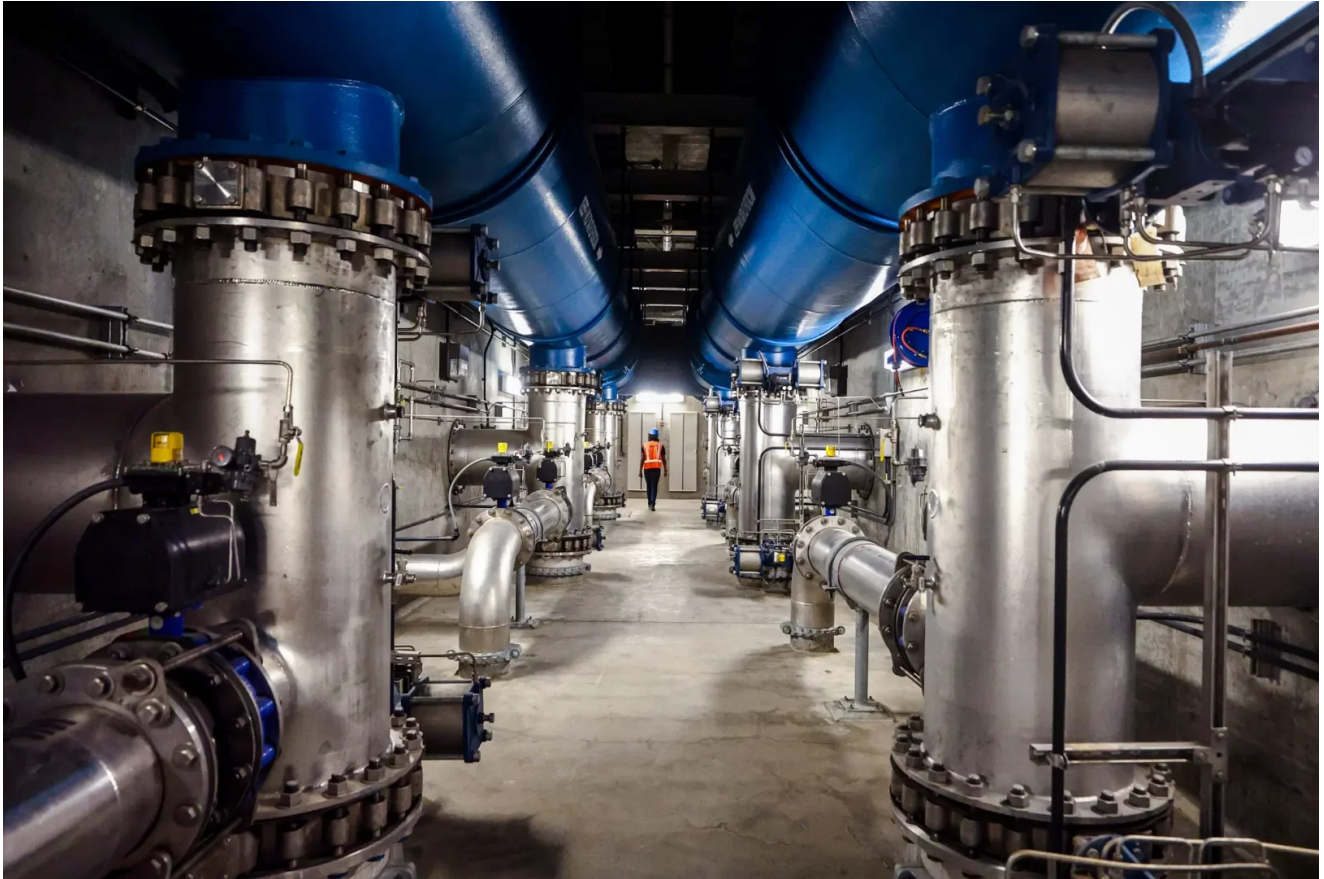
Odpadní voda prochází procesem mikrofiltrace v největším zařízení na recyklaci odpadních vod na světě, v Orange County Water District ve Fountain Valley v Kalifornii, 20. července 2022. (Mario Tama / Getty Images)
