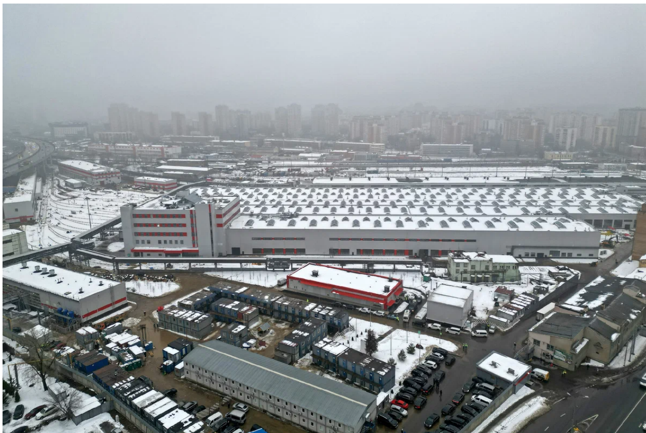
Elektrické depo "Nižnij Novgorod".
