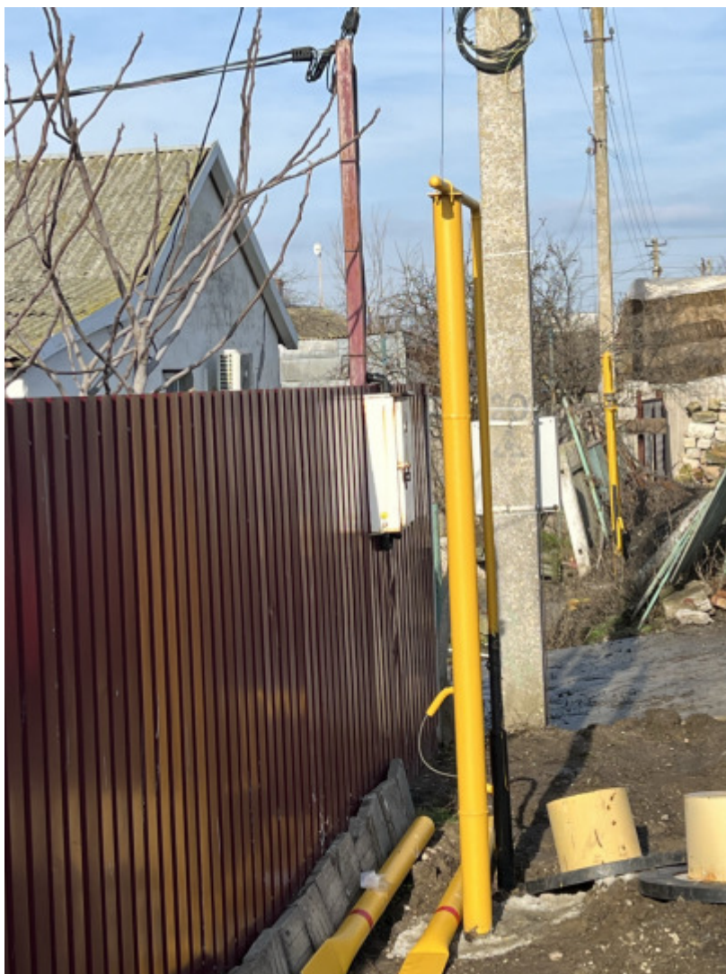
Instalace plynového vedení před domem Fatimy v Batalnoje, leden 2024.
