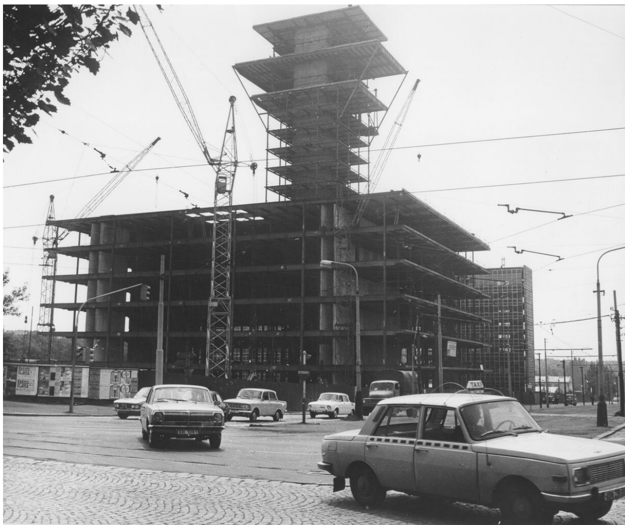
Průběh stavby v sedmdesátých letech
