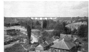
Železniční viadukt přes Tsaritsa (postaven v roce 1898). Nyní je na tomto místě hliněné nábřeží mezi ulicemi Simbirskaaya a Glubokoovrazhnaya
