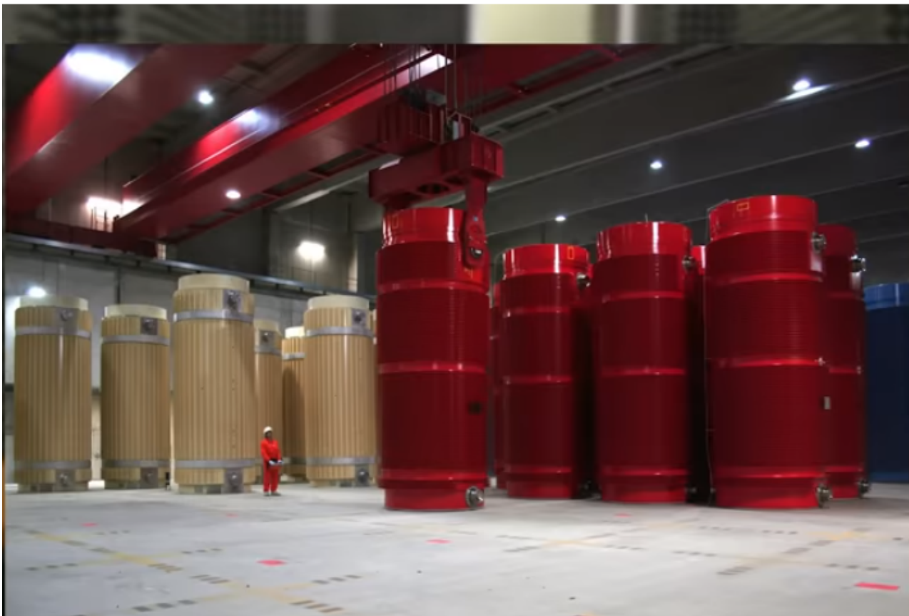
Sklad vyhořelého paliva na JE
