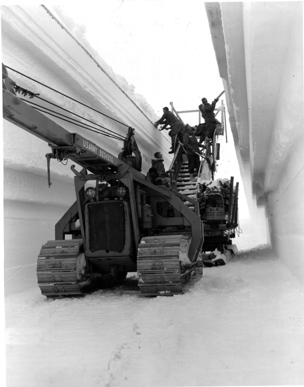
Personál umisťující obloukové podpěry do tunelu do hlavního příkopu v Century Camp. (Photo Credit: Pictorial Parade / Archive Photos / Getty Images)
