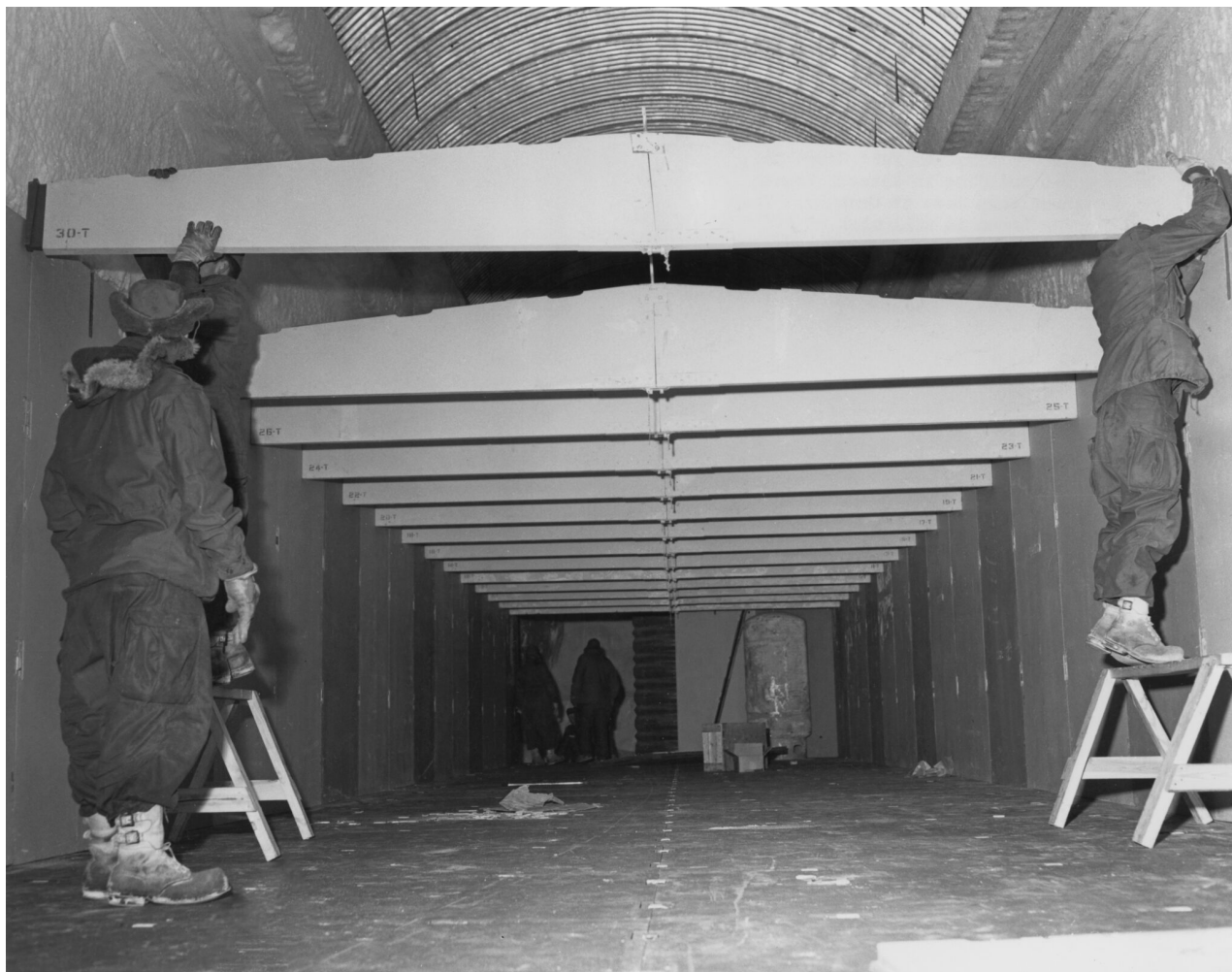
Pracovníci Polárního výzkumného a vývojového centra US Army staví budovu „T5“ v bočním příkopu v Camp Century, 1959. (Foto: US Army / Pictorial Parade / Archive Photos / Getty Images)
