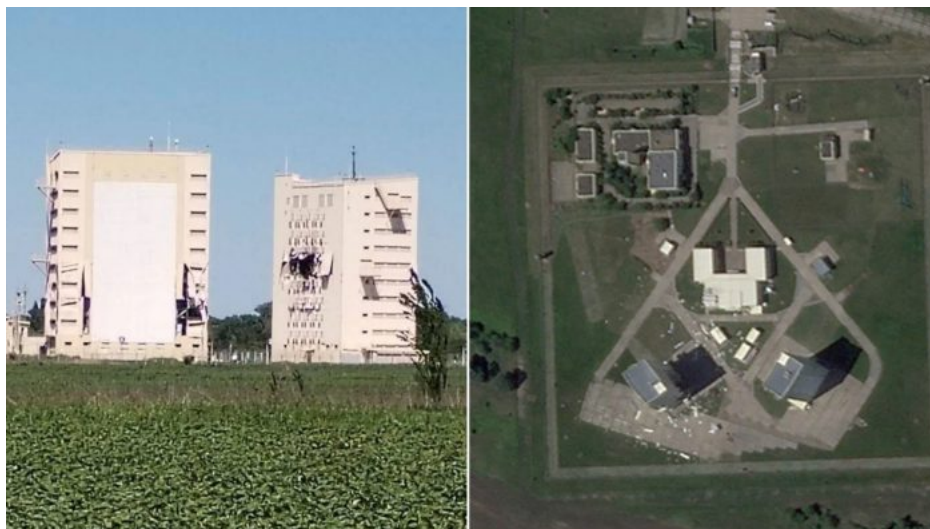
Poškozené vysílače zahorizontálních radarů v Armaviru a satelitní snímek
